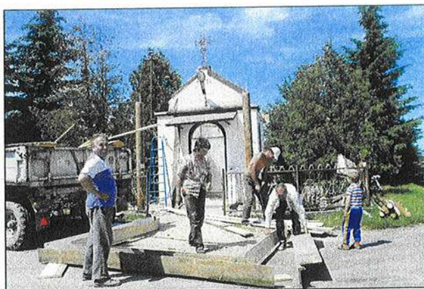
Mieszkańcy remontujący kapliczkę.
