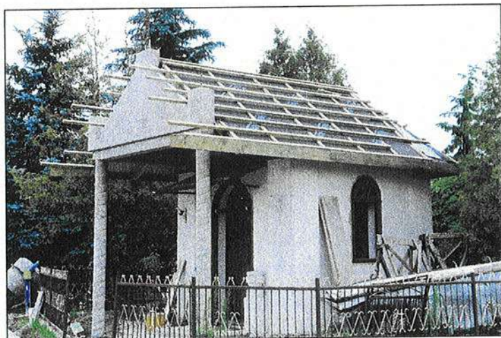
Kapliczka w trakcie remontu.
